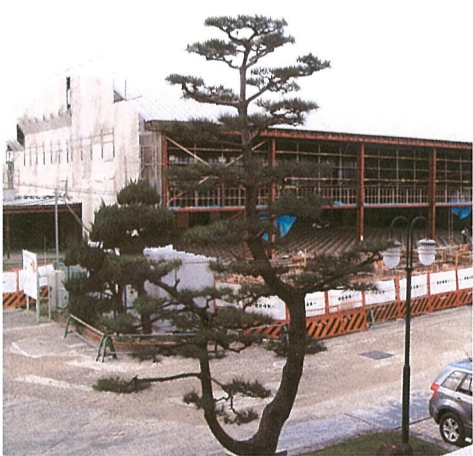
鉄骨がむき出しになった改修中の体育館 平成19年
